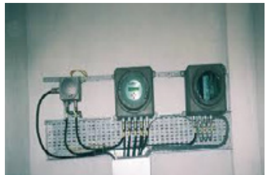
Onaylanması gereken tesisat
