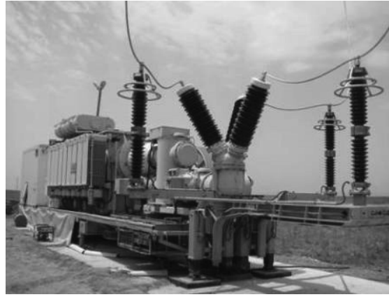
Resim 5 Daha önce Bingöl TM'de bulunan 154/34,5 kV, 25 (31,25) MVA ABB marka Mobil trafo Diyarbakır'da Bismil TM F- 10 hattı ile Mazıdağı Etifosfat hattının kesiştiği noktada Bismil bölgesinin tarımsal elektrik ihtiyacını karşılamak için bölgeye getirildi. Görevini tamamlaması sonrasında gönderildi.
