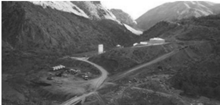
Resim 20. Baraj Yerinden Görünüm
