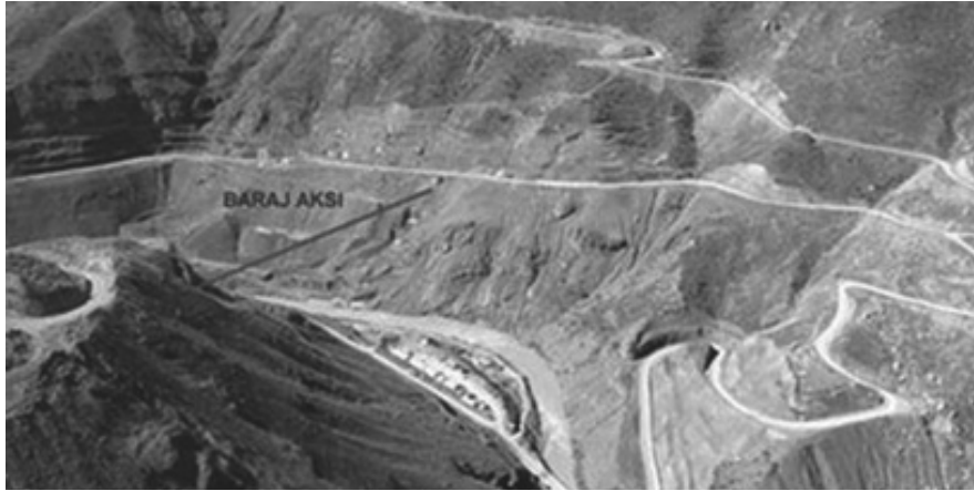
Resim 19. Baraj Yerinden Görünüm
