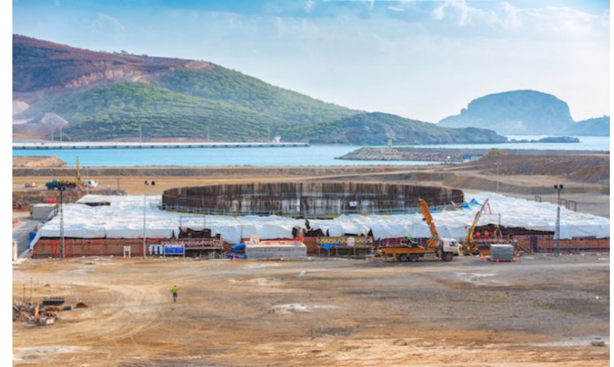
Fotoğraf 1 Akkuyu NGS İnşaat sahası reaktör temeli (Kaynak https://www.enerjigunlugu.net/akkuyu-ngs-inaatinin-guvenligini-assystem-saglayacak-31997h.htm , 02.05.2019)
