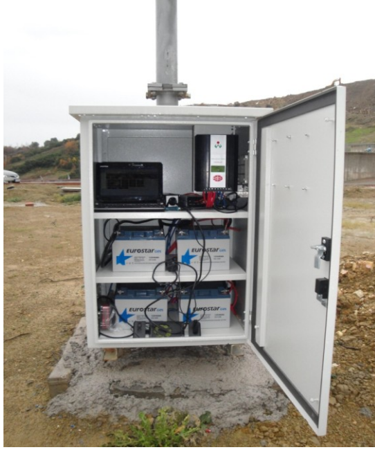
Şekil 6. Fotovoltaik enerji depolama sistemi, şarj kontrol cihazı, akü gurubu ve enerji kayıt sistemi fotoğrafı.
