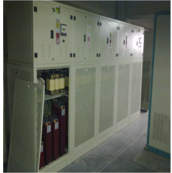
Şekil 3: 1.Fırına Ait Aktif Harmonik Filtreli Kompanzasyon
