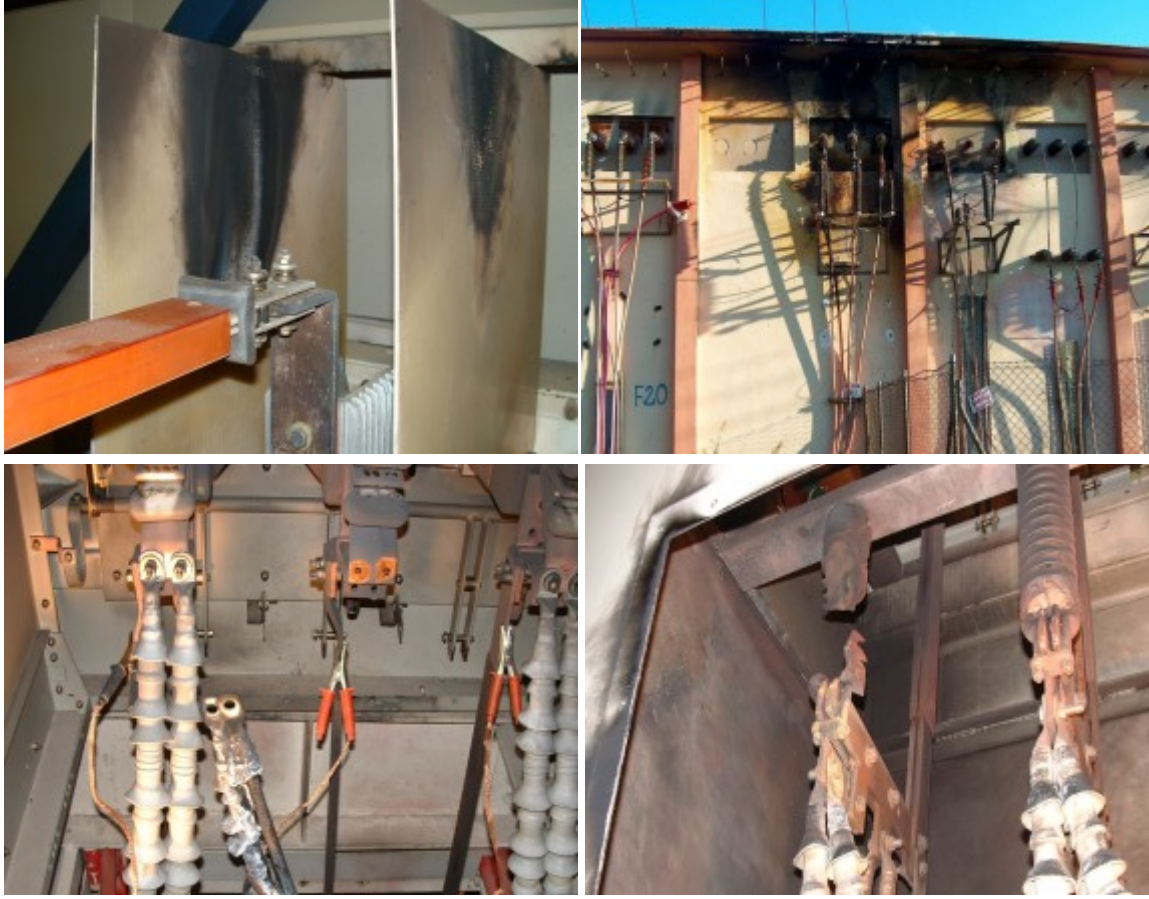
Şekil 3a-b-c-d: Arıza Örnekleri; a)OG kesicinde kapama anında oluşan kısadevre, b)Parafudr arızası, c)Kablo başlığı arızası, d)Mesnet izolatörü arızası
