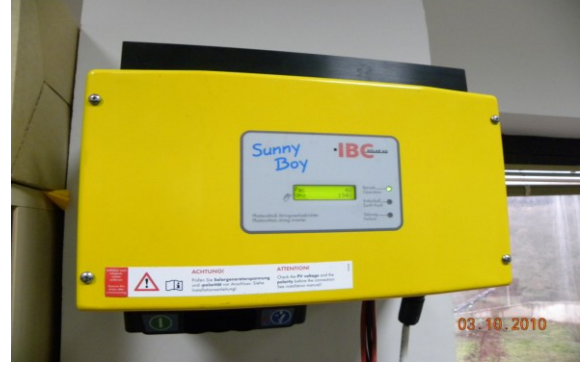
Şekil 5. Şebeke bağlantılı evirici fotoğrafı.
