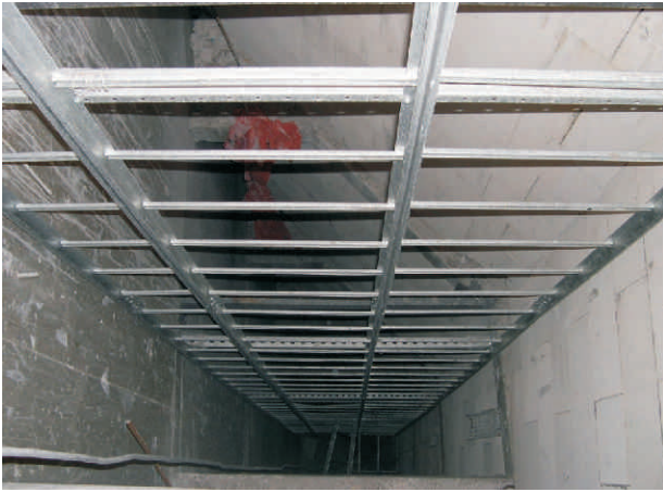
Kablo Bacasında Kablo Merdiveni Görünüşü
