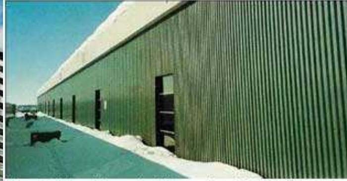
Kanada Hava Kuvvetleri Hangarları (10.000m 2 )
