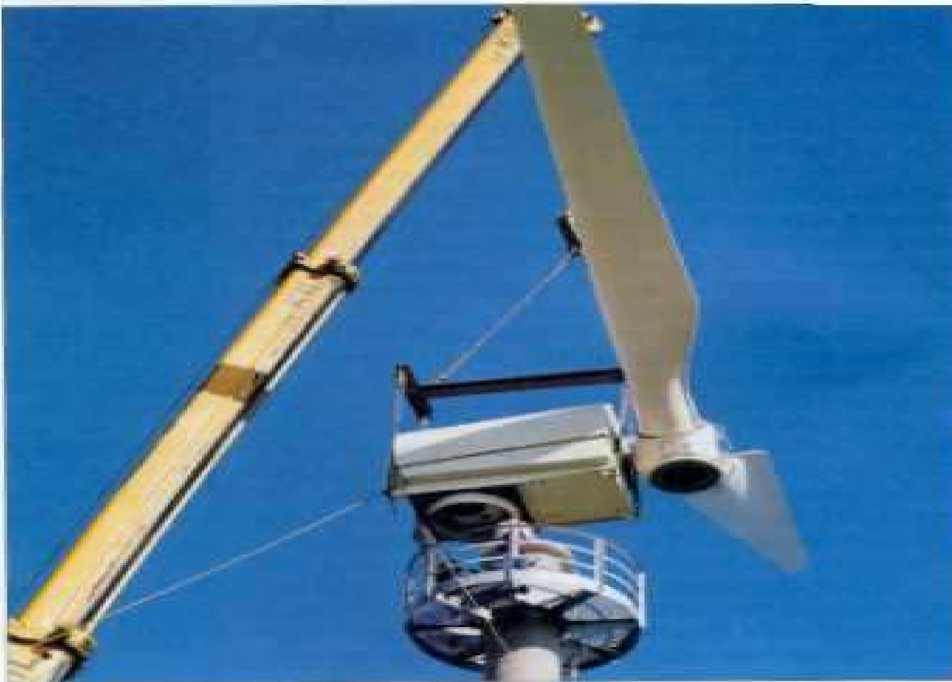
Abb. 1: Errichtung einer Nordwind NW 31/3/250 im Windpark Waardpolder
