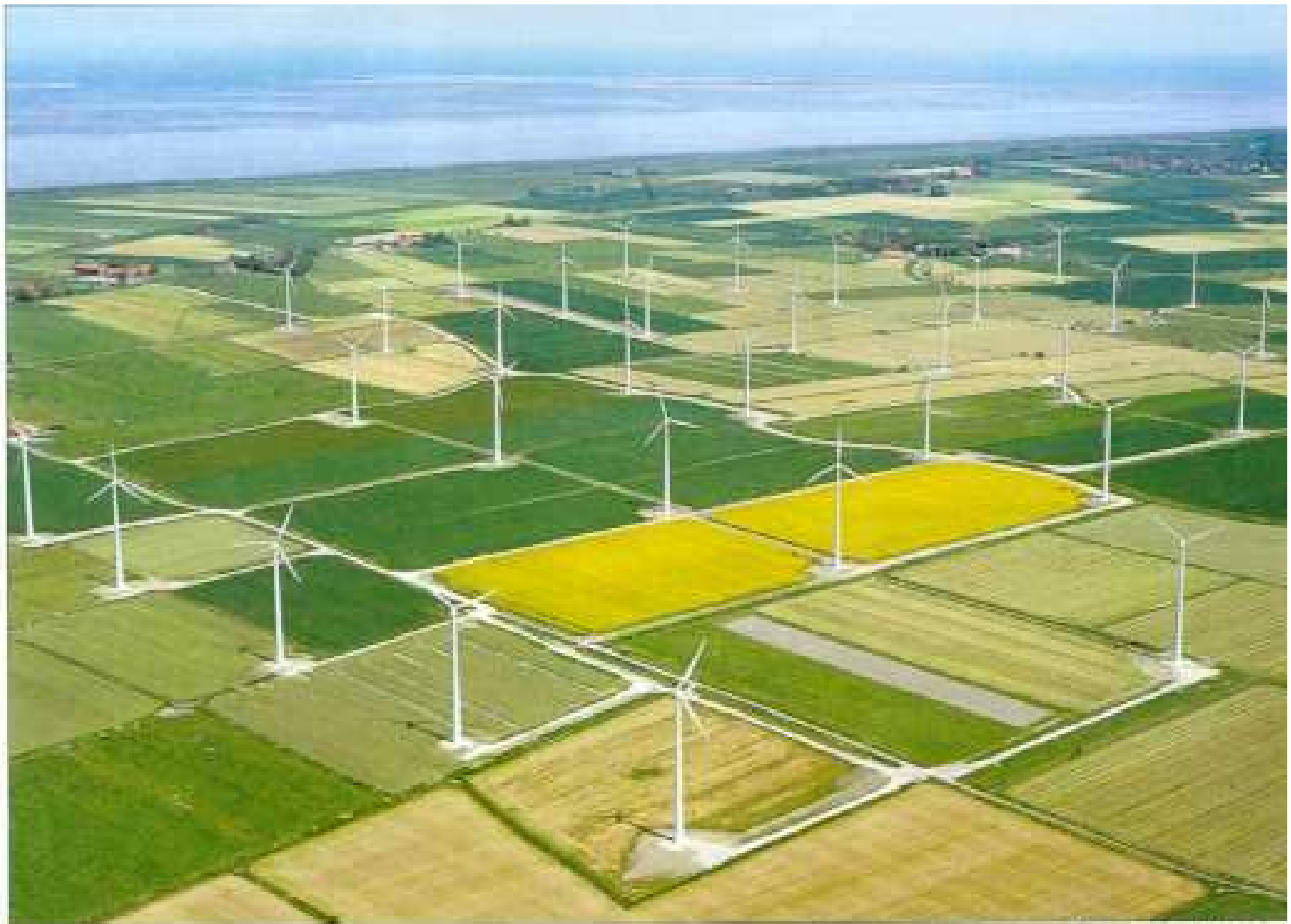
Der Bürgerwindpark Bassens aus der Luft betrachtet: Das Oldenburger Büro «Projekt» plante den Park mit insgesamt 34 AN Bo-
