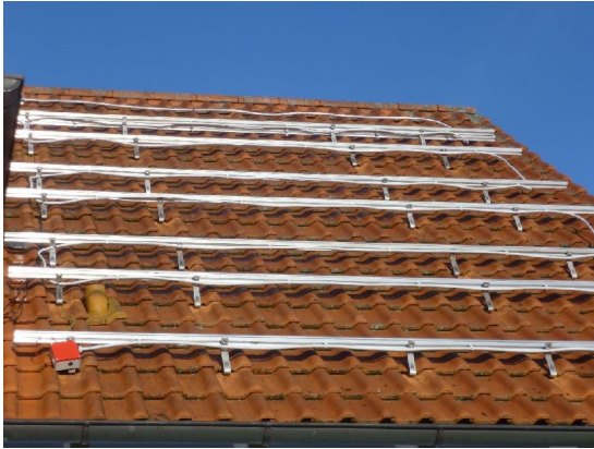
Şekil 3. Kablo tipi sıcaklık dedektörü montajı-2
