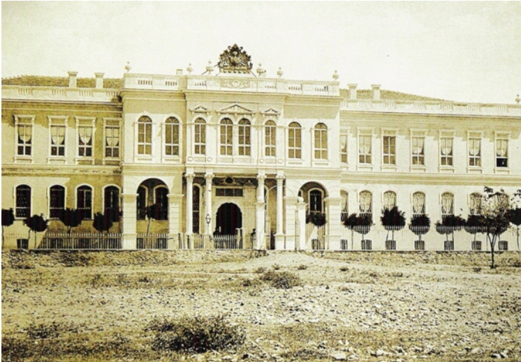
Resim 2- 1881'de yenilenen İstanbul - Halıcıoğlu'ndaki yeni Mühendishâne-i Berrî Hümayûn binası.
