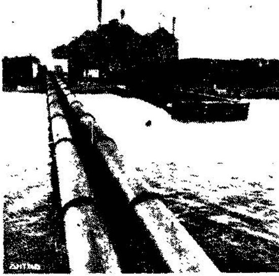
Denizde kazık çakılması için iskele
