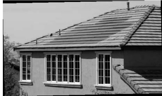
Şekil 2. Yapıda çatı kiremidine entegre edilmiş panel uygulaması (Anonim, 2008a).
