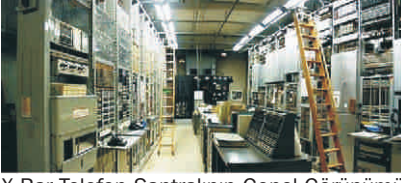
X-Bar Telefon Santralının Genel Görünümü
