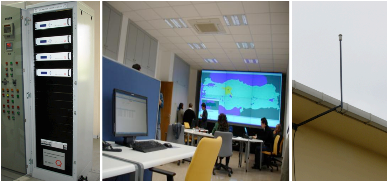
Şekil- 3 Milli Güç Kalitesi Panosu, İzleme Merkezi ve GPS Anteni
