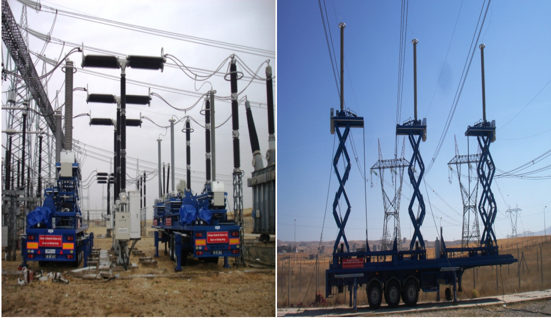
Şekil- 11 Geçici Rejim Ölçüm Altyapısı
