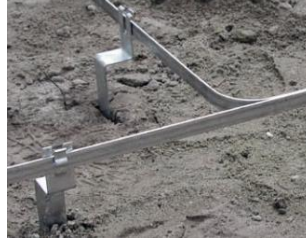
Temel top. membran altı Grobeton içerisinde yapılıyor(DEHN)
