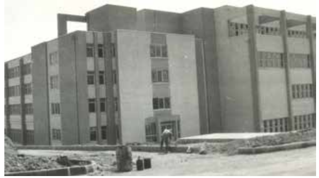
İTÜ Ayazağa yerleşkesindeki Elektrik-Elektronik Fakültesi Binasının inşaatı (1980, İTÜ Arşivi)
