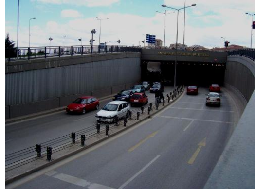
Resim 3 : Yetersiz giriş aydınlatması
