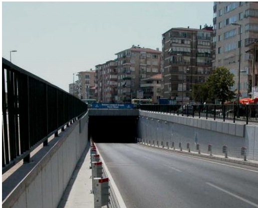
Resim 1 : Gündüz şartlarında alt geçit girişinde kara delik etkisi
