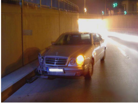
Resim 4 : Gece şartlarına uygun olmayan alt geçit aydınlatma sistemi.
