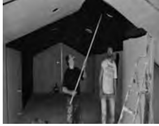
Resim 4 EM kalkanlama boyası uygulanan çatı katı [3].
