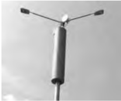
Resim 1 Sokak lambasına gizlenmiş antenler ve beyaz mini radyo link cihazı [1].
