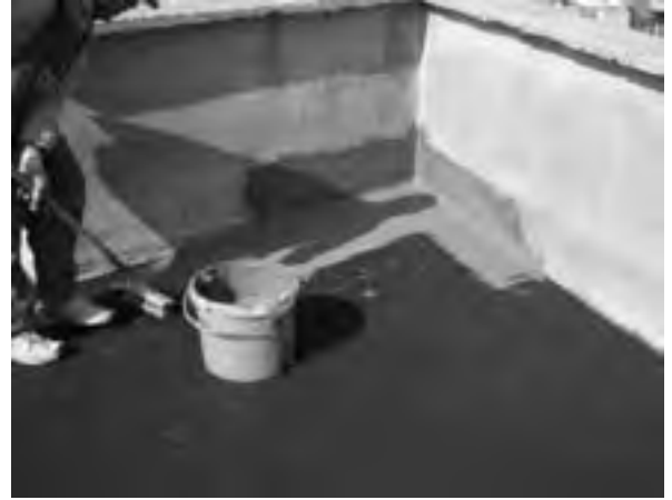
Resim 7 Baz istasyonu altı çatı EM izolasyonu [6]
