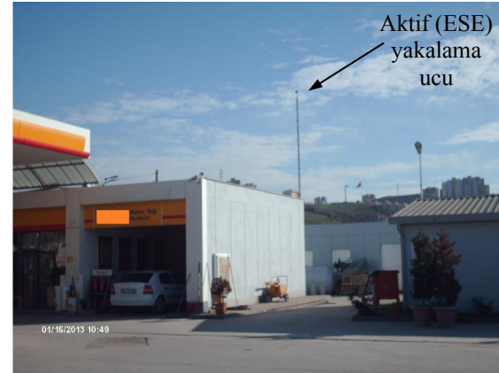
Şekil 6. Yaygın olarak kullanılan aktif (ESE) yıldırımlık uygulama örneği.
