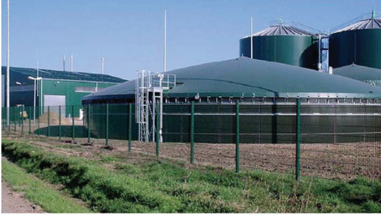
Resim N-09. Modern bir tesiste yeni usullere göre yapılan PARATONER yıldırımından korunma örneği
