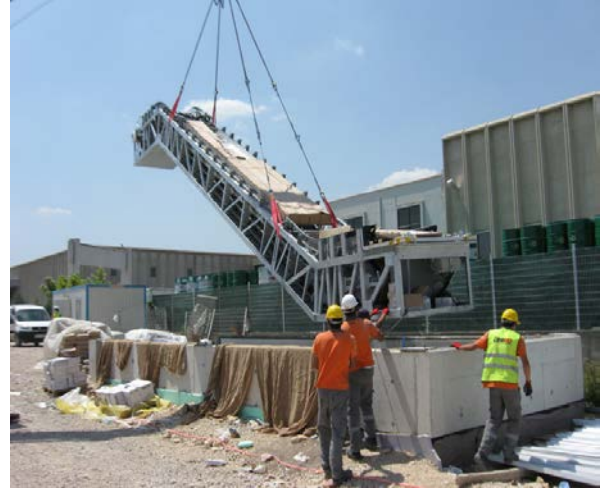
Muayeneleri yapılmış kaldırma ekipmanlarının kullanılması gerekmektedir.
