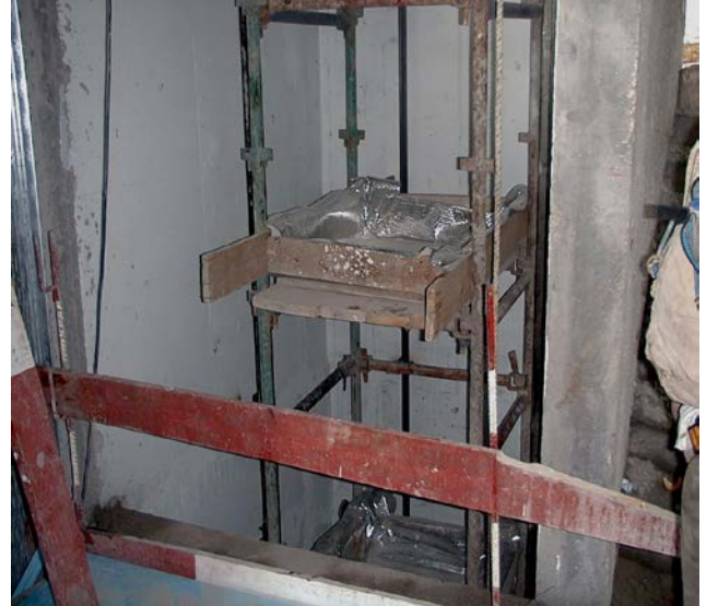
İskele üzerinde uygunuz çalışma platformları
