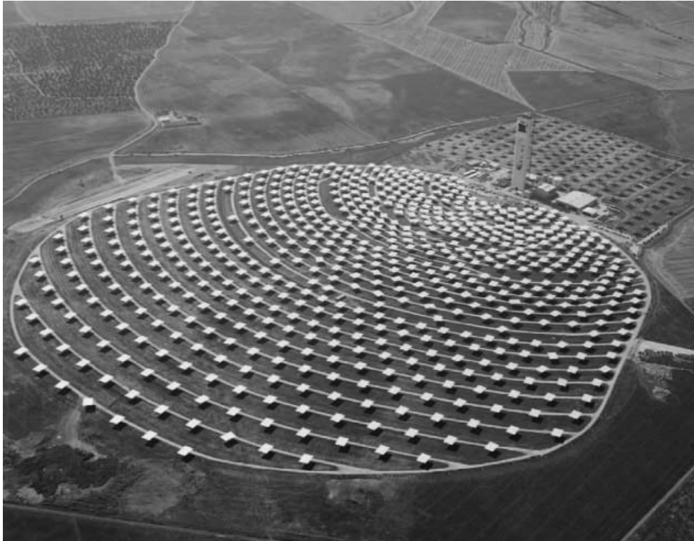
Şekil 6. İspanya'da kurulan PS10 güç kulesi [1]
