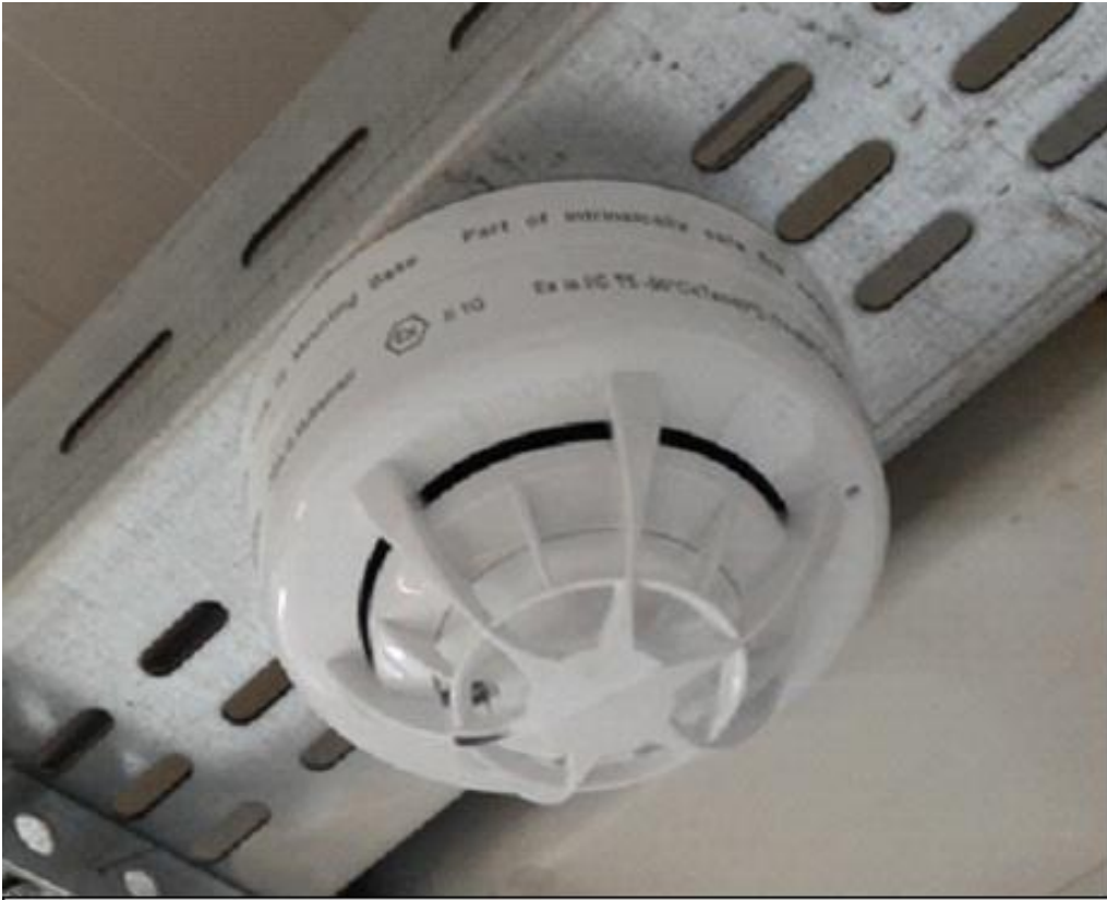
Resim 3-10: Duman detektörü görünüşü ve üzerindeki bilgiler
