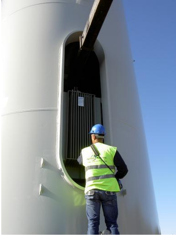
Şekil.2. Rüzgâr türbini içerisine monte edilmiş transformatör [1]
