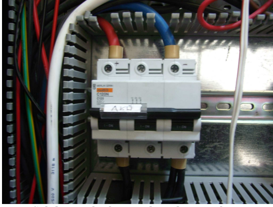
Şekil 16. Akü hattı voltaj ölçüm noktası
