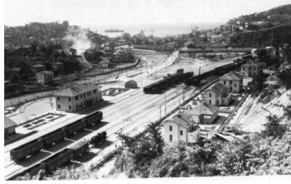
Zonguldak istasyonu yapım çalışmaları. (1937)
