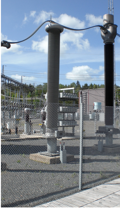
Şekil 4. 300 kV'luk HVDC hatlarında kullanılan gerilim bölücüsü
