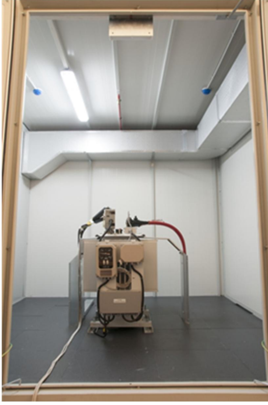
Şekil 3. Örnek Trafo Odası
