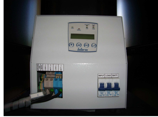
Şekil 9: Şebekeden akü şarjı için şarj cihazı.
