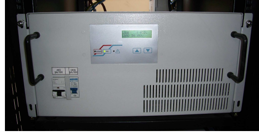
Şekil 13: Yakıt pili sistemlerinin çıkışındaki 220V/50Hz tam sinüs invertör.
