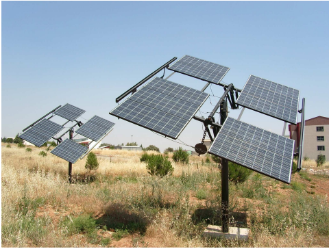
Şekil 4: Sıvı bazlı güneş takip düzenekleri üzerindeki fotovoltaik paneller.
