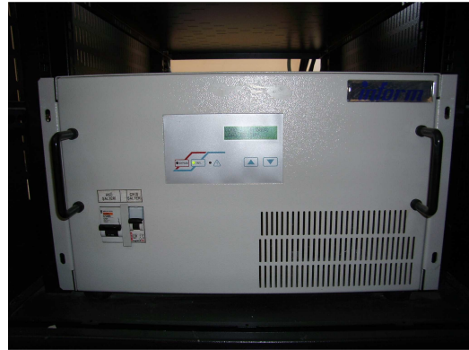
Şekil 10: 5kW tam sinüs invertör.
