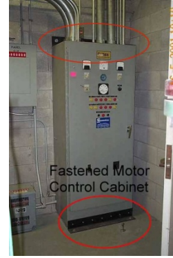
Şekil 30a, 30b. Döşemeye oturan dikili tip panoların çelik profiller yardımıyla deprem koruması
