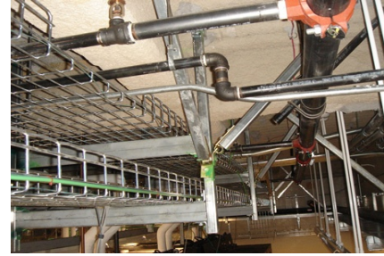
Şekil 34a, 34b. Tesisatların çelik profiller yardımıyla deprem koruması
