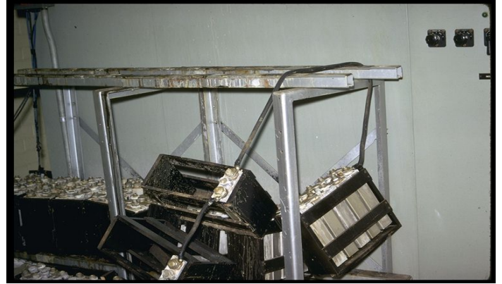
Şekil 4. Sınırlandırılmamış akü ve raflardaki hasar oluşumu [8]
