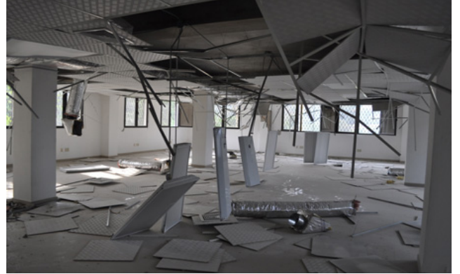
Şekil 6a, 6b. Asma tavanlara bağlantıları gerçekleştirilmiş aydınlatma armatürleri [8]
