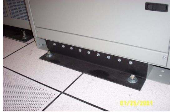
Şekil 37a, 37b. Yüzer döşeme ve üzerine oturan ekipmanların deprem koruması
