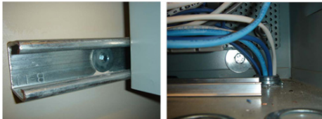
Şekil 33. Sıva üstü panoların taşıyıcı olmayan duvarlara bağlantısı
