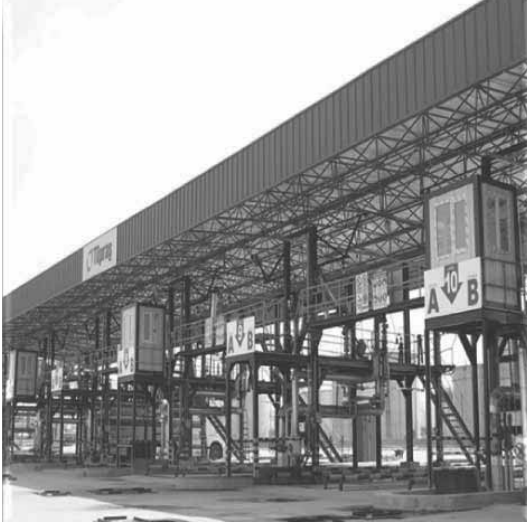
Şekil 10: Kara/Vagon Dolum sistemlerinde modernizasyon ve iyileştirme çalışmaları ve alttan dolum sistemi ile emisyonların azaltılması
