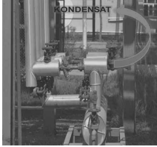
Şekil 2: Kondensat Geri Kazanım Sistemi
