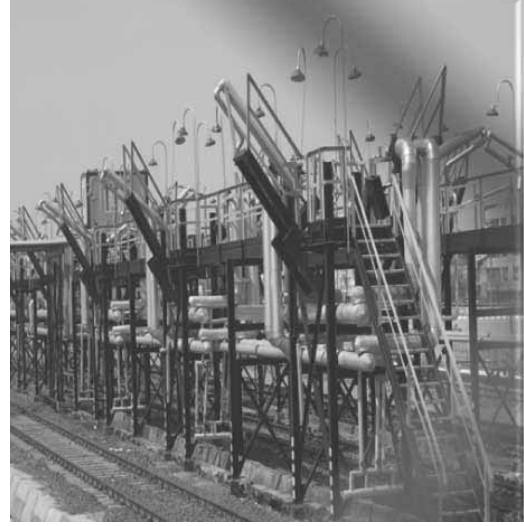
Şekil 10: Kara/Vagon Dolum sistemlerinde modernizasyon ve iyileştirme çalışmaları ve alttan dolum sistemi ile emisyonların azaltılması
