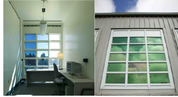
Şekil 6 Elektrokromik Camın 3 Farklı Durumda Kullanımı [7]
