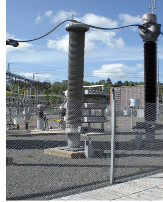
Şekil 1. 300 kV'luk HVDC hatlarında kullanılan gerilim bölücüsü
