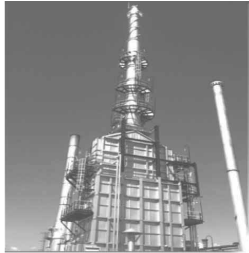
Şekil 6: Plant-100 F-101 fırın değişim projesi ile fuel oil tasarrufu
