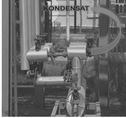
Şekil 2: Kondensat Geri Kazanım Sistemi
