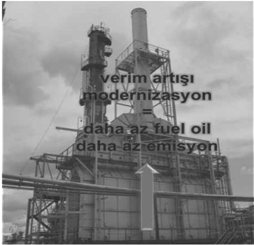
Şekil 5: Plant-1100 F-1101 fırın verimi iyileştirme projesi ile fuel oil tasarrufu
