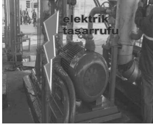
Şekil 4: Rafineri genelinde 31 adet pompa, fan ve kompresörlere VSD uygulama projesi ile elektrik tasarrufu
