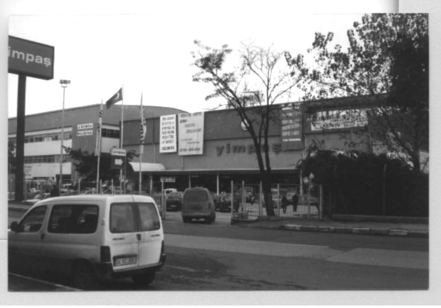
Önce ARLA'ya sonra TELETAŞ'ın Ar-Ge'sine ev sahipliği yapan binanın çağdaş görünümü!
