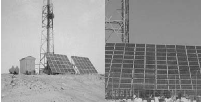
Şekil 10 - Baz istasyonunu elektrik enerjisi ihtiyacının güneş enerjisiyle sağlanmasına örnek
