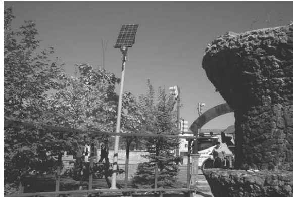
Şekil 8 - Park ve bahçelerde güneş enerjisi uygulaması
