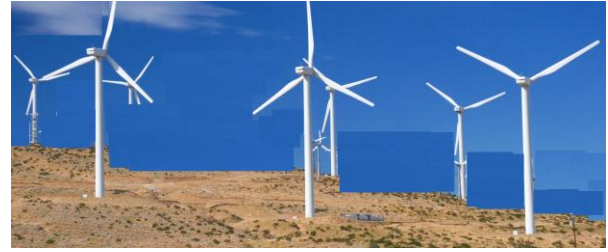
Şekil 8. Tarsus İlçesinin sekiz km kuzeyindeki orman özelliğini yitirmiş arazi ve planlanan rüzgar enerji santrali
