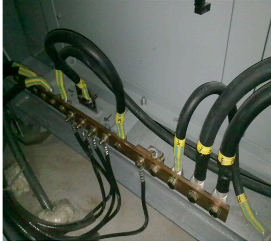
Şekil-4: Eş Potansiyel Topraklama Barası [6]
