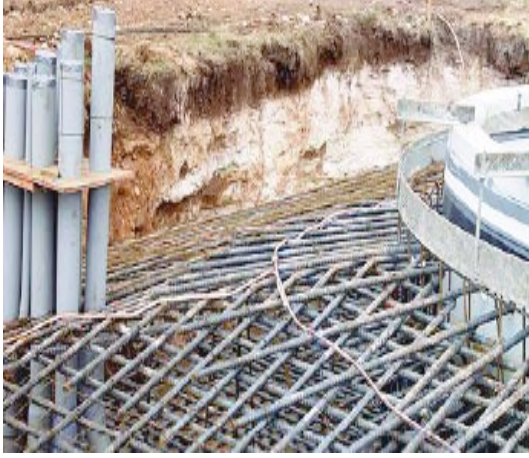
Şekil-3: Rüzgar türbini Temel Topraklaması [5]
