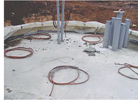
Şekil-2:Rüzgâr türbini Temel Topraklamasından Çıkan Filizler [5]
