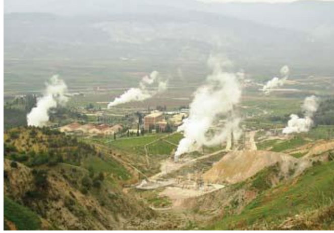
Şekil 6. Zorlu Enerji Jeotermal Santral Sahası [6]
