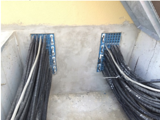
Şekil 7 Kablo Kanalı Sonra
