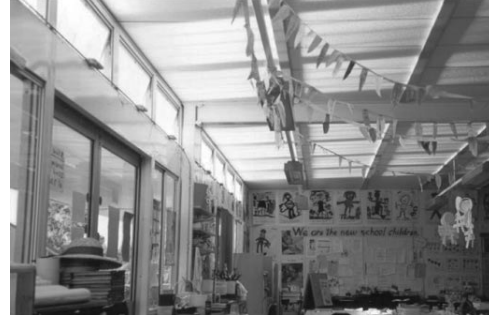
Şekil 4 Işık yönlendirici sistem olarak lazer kesim panel uygulaması, Kenmore South State School, Brisbane, Australia. [2]
