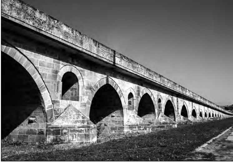
Ülkemizin en uzun kargir köprüsü olma özelliğine sahip olan Uzunköprü (Edirne), önce II Murat tarafından ahşap köprü olarak yaptırılmıştır, daha sonra kargire çevrilmiştir.
