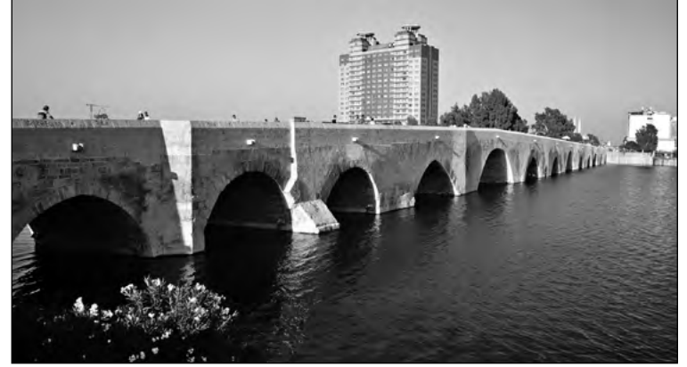
Roma Dönemi köprülerinden olan Taş Köprü (Adana), farklı dönemlerde geçirdiği restorasyonların ardından hala kullanılmaktadır.
