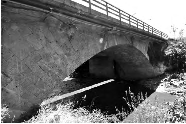
Geçit Köprüsü (Bursa)
