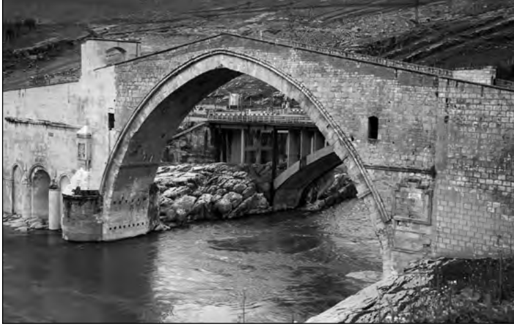
12. yy. Selçuklu Dönemi başyapıtlarından olan Malabadi Köprüsü, dünyanın günümüze ulaşan en büyük kemer açıklığına sahip taş kemer köprüsüdür.
