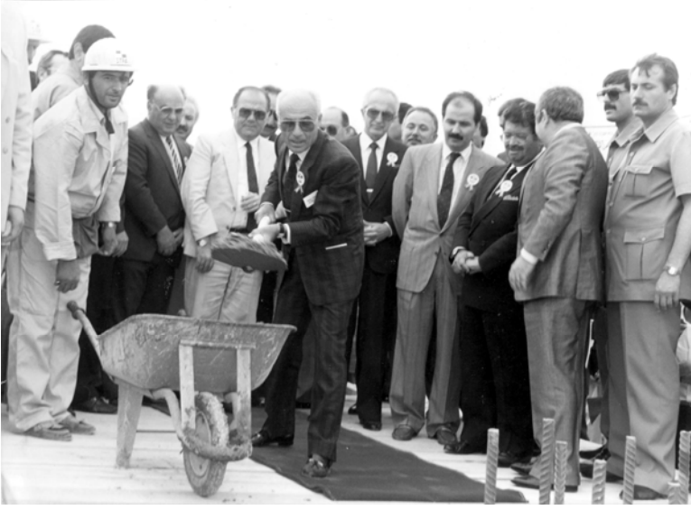
16 Ağustos, 1987. Dudullu Binası'nın Temel Atma Töreni'nden bir görünüş.
