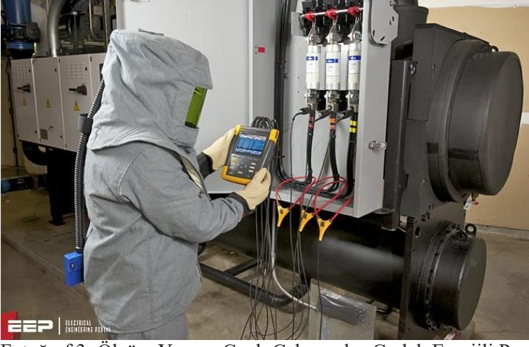
Fotoğraf 3: Ölçüm Yapma Canlı Çalışmadır. Çıplak Enerjili Parça Varsa Arka Karşı Kıyafet Giyilmelidir.
