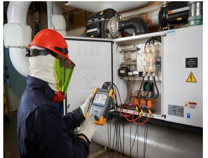
Fotoğraf 1: Ana Dağıtım Panolarının Önünde Harmonik Ölçümü Yaparken Ark Kıyafetleri APC2 Olmalıdır.
