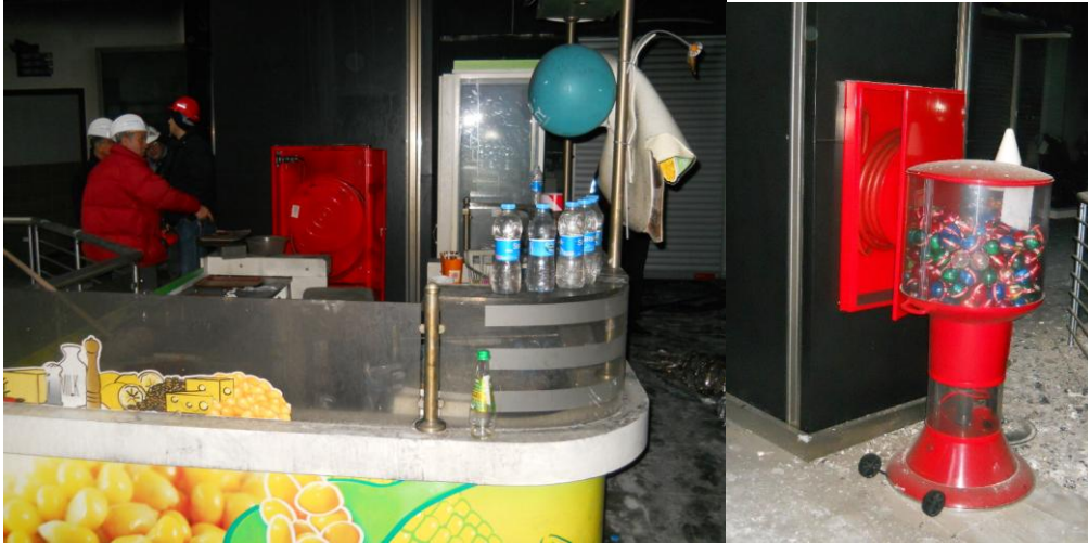
Şekil 1. Yangın dolaplarına ulaşımın engellendiği görülmektedir.
