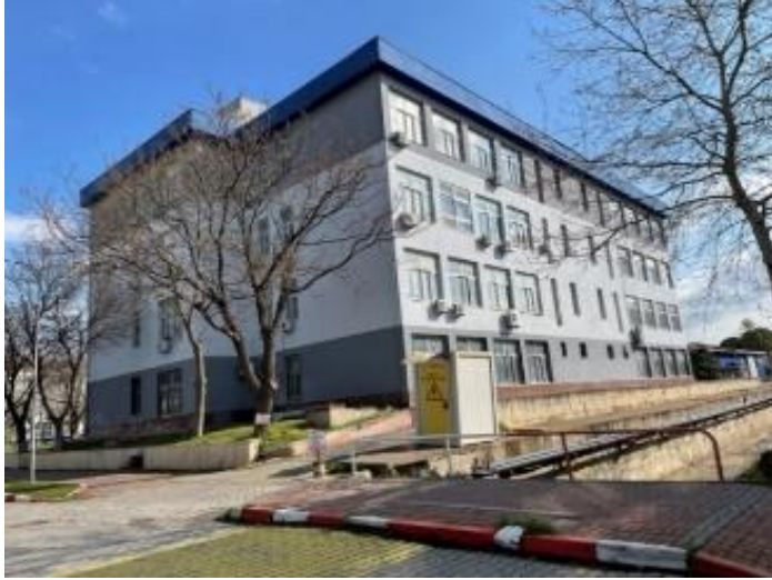
Şekil 3. Ege Üniversitesi İnşaat Mühendisliği binası güney cephe görünüşü
