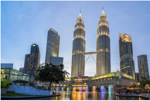
Şekil-2: Bina İçi Sistem Kurulumu Yapılmış Bazı Örnek Binalar [4]
