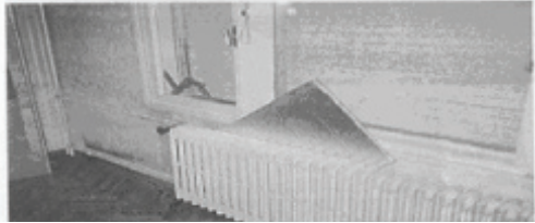
Radyatör arkasına ısıtım ısı yalıtım levhası konularak ısı kaybının azaltılması
