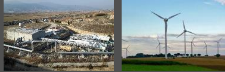
Grubun ilk jeotermal enerji santrali olan Bereket Jeotermal Enerji Üretim ve Grubun ilk rüzgar santrali Uşak RES işletmeye alınır
