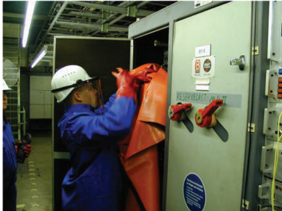
Fotoğraf 4. Canlı Hattın İzole Edilmesi
