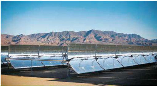
Şekil 1. Nevada Solar One, 64 MW'lık parabolik çizgisel odaklayıcı sistem.(Bilim ve Teknik Mayıs 2009)
