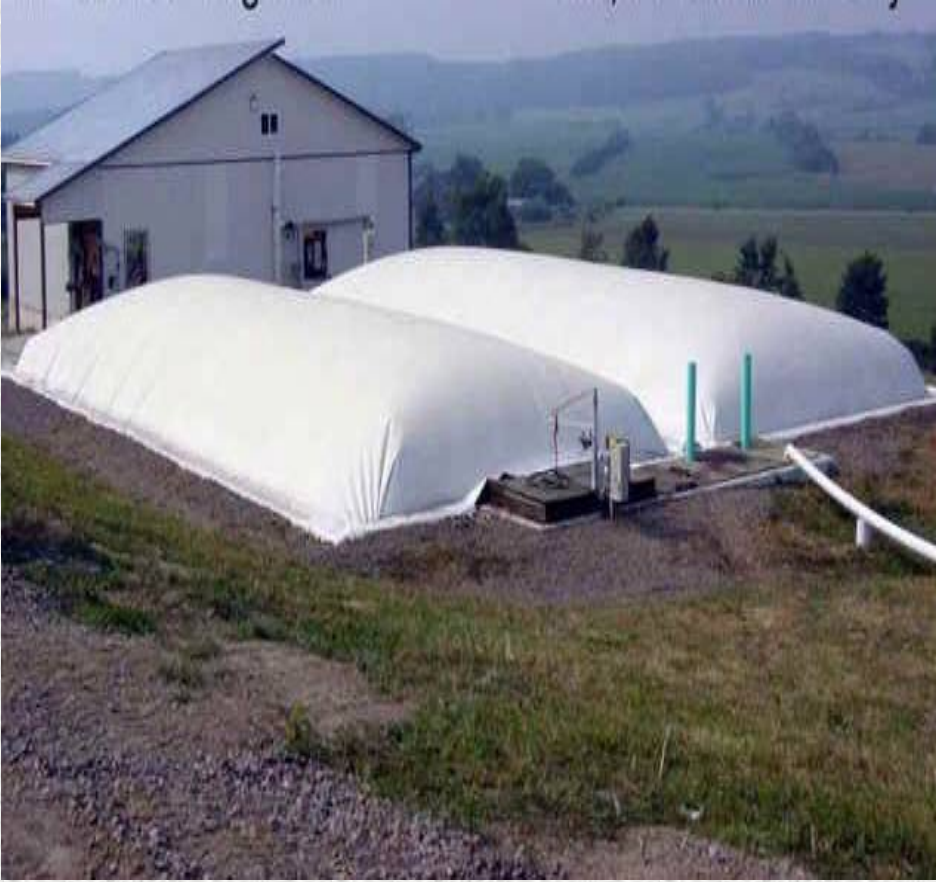
Tam karışimli ,2 831 684 L biogaz ve 135 kW enerji üretim kapasiteli reaktörün görüntüsü
